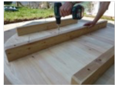
Festschrauben der Trägerbalken
