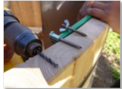
Bohren Sie nicht zu tief. Max. 3.5cm
