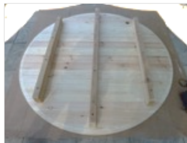
Trägerbalken auf Boden
